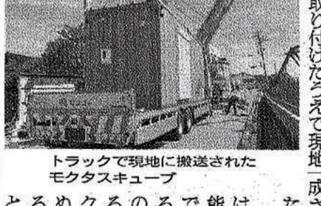
トラックで現地に搬送されたモクタスキューブ
